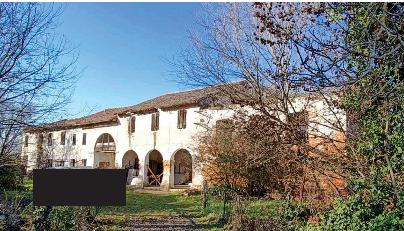
Foto 02 – prospetto sud fabbricato principale
